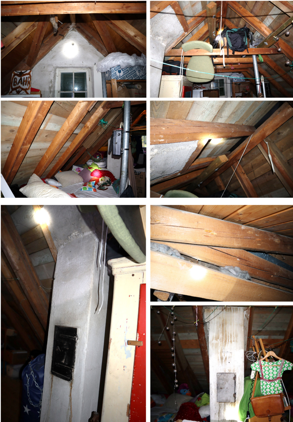
Abbildung 3: Fotos des Dachbodens des zu kontrollierenden Gebäudes
