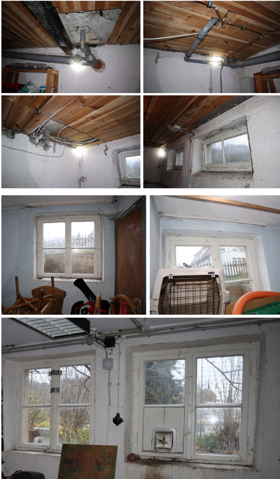
Abbildung 2: Fotos der Kellerräume des zu kontrollierenden Gebäudes
