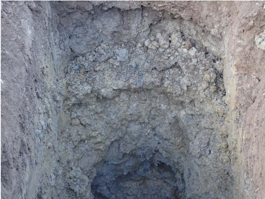
Bild 2, Schürfgarbe SG1, Wasserzutritt zwischen 0,90 – 1,40 m u. GOK
