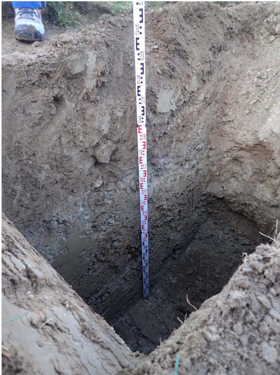
Bild 4, Schürfgrube SG2 bis Endtiefe
